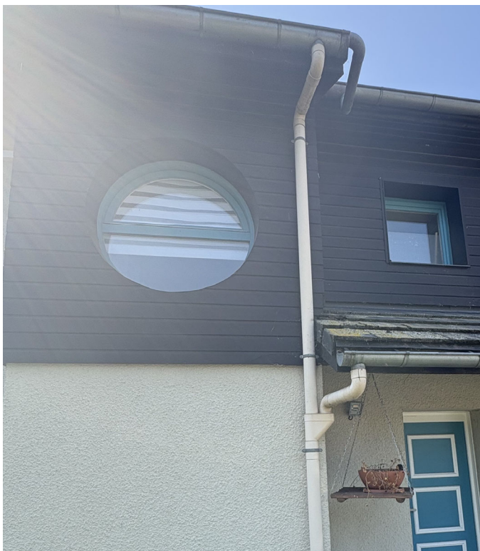
Figure 3 Menuiserie circulaire (œil de bœuf) au droit escalier intérieur et porte d'entrée PVC.
